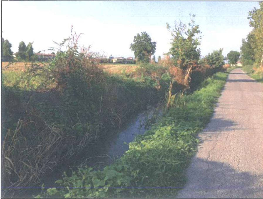
Argine quasi del tutto privo di vegetazione
